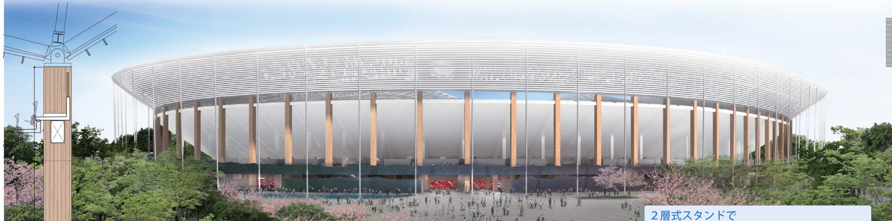
72本の純木製の列柱と中間層免震によって、浮遊する屋根と清々しいスタンドを実現します
