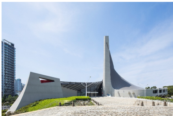
国立代代木竞技场第二体育館正面入口外観
